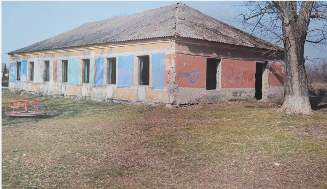
Малюнок 5.2. Застаріла та покинута будівля, яку можна використовувати, як соціальне житло – вул. Центральна, 6, с. Михайлівка
